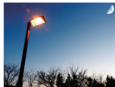
公共施設郊外灯設備の 施工・メンテナンス
