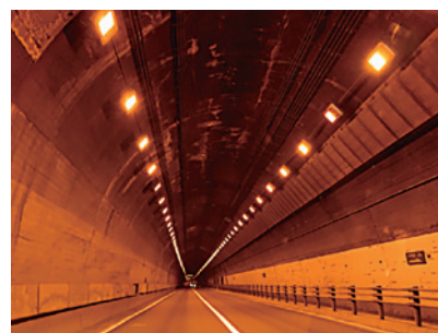
トンネル 照明設備の 施工・メンテナンス
