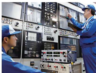
計装設備機器配管配線
