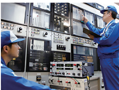
計装設備機器配管配線
